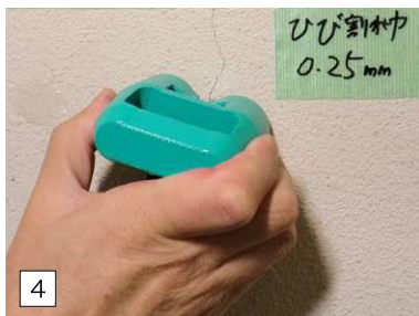
4 探触子に接触媒質を塗布し、ひび割れを挟んで探触子を押し当てる
