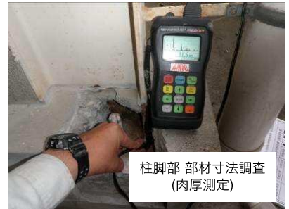
柱脚部 部材寸法調査
