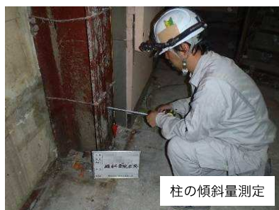
柱の傾斜量測定
