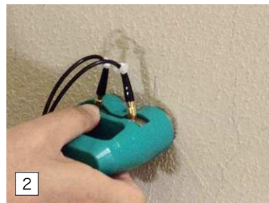
2 探触子に接触媒質を塗布し、近傍健全部に探触子を押し当てる
