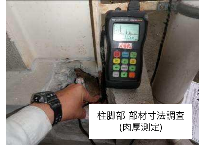
柱脚部 部材寸法調査
