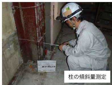
柱の傾斜量測定
